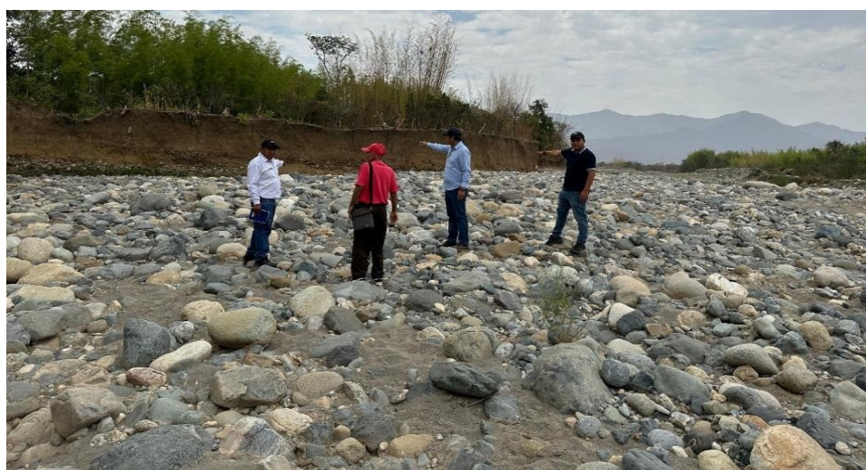
Figura N° 02: Se observa el Rio Bigote en el Sector La Quemazon, colmatado y tambien con uno de sus márgenes socavados, afectando la zona agricola de la zona.
